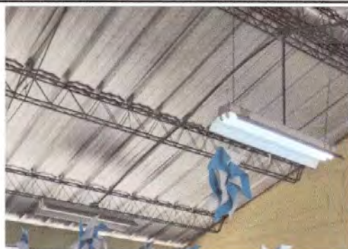
Foto 3: Reparación de lámparas
