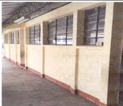
Foto1: Pintura en muros exteriores e interiores
