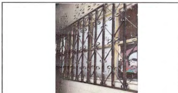
Foto 5: Sustitución de balcones de metal
