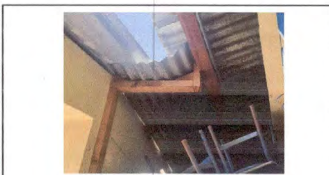
Foto 6: Sustitución de canales de metal
